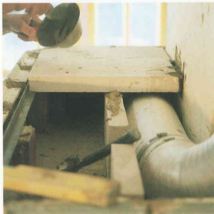
40 Letzte Kachelreihe, Warmluftrohr-Führung und Abdeckung mit Gasbeton- platten
