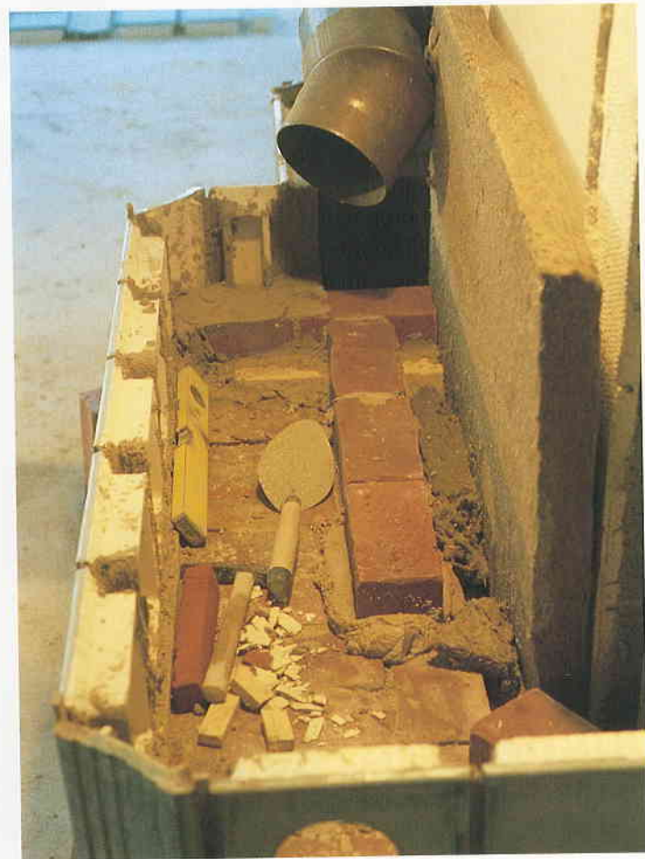
23 Das Bild zeigt die ersten Schritte zum Bau der Ofen- bzw. Zugrückwand; oben erkennt man das vormontierte Rauchrohr, rechts die Schornstein-Isolierung
