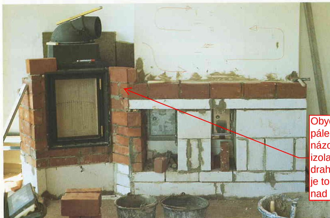
56 Wandisolierung und Sockelerhöhung bis zur Oberkante der Reinigungsöffnungen im Schornstein
